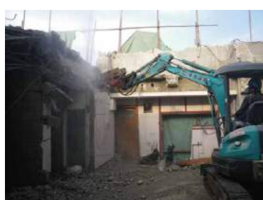
8月 解体中は、狭い上に隣地が接近していて、細心の注意を払いながらの作業でした。
