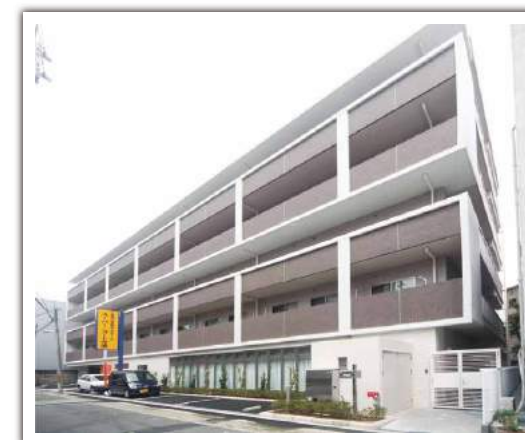
スーパーコート今里新築工事 設計者:(株)アーキスタンド1級建築士事務所 完成日:2015年8月 構造・規模:S造 5F 延床面積3349㎡
