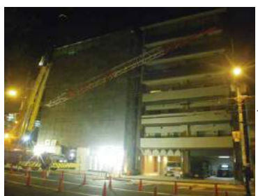
4月 タワークレーンは、近所の方からも「大きいね」など感想いただきました。クレーンの解体は、深夜作業を余儀なくされました。夜間業務お疲れさまでした。
