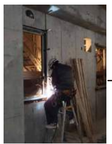
27年2月 鋼製建具の溶接取付の状況です。
