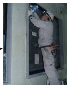
2月 ガラスが組み込まれて、防火シーリングを打ち込んでいる状況です。
