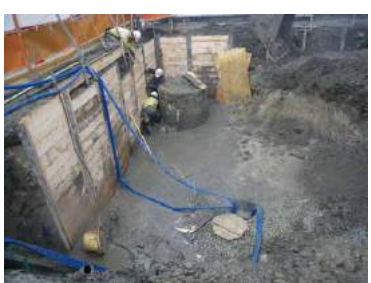
9月 掘削中の地下水が大変多くて難関でした。特に北側は深かったため、土留め完了まで大変でした。
