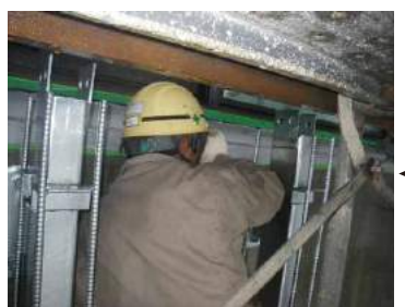
4月 外壁のアクセントとなっている間柱は鉄骨が軸となっています。建て込みは一苦勞でした。
