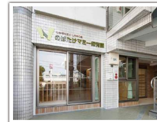
のばたけまみー保育園整備工事 設計者:大塚謙太郎1級建築士事務所 完成日:2015年8月 構造・規模:S造 2F 延床面積825.96㎡
