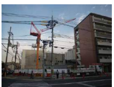
9月 基礎・埋め戻しの直後、タワークレーンを設置完了しました。近所の方から「大きいクレーンが立ったね〜っ」との感想をいただくこともしばしばでした。
