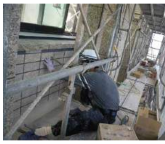
5月 一番こだわった、石とタイルを組み合わせの外壁仕上げです。毎晩遅くまで納得のいく仕事をされたと聞いています。
