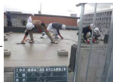
3月 屋上防水の最終段階では、軽量コンクリートを打ち込んだ後、左官工事業者さんたちが腕を競ってのこテ押さえです。今春は、雨が続いたのでこの日を選ぶ段取りも、皆大変でした。
