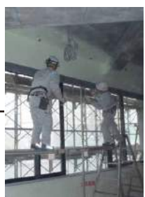
4月 金属性のカーテンボックスのセッティング中。
