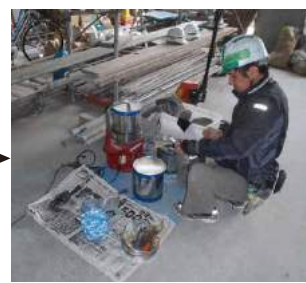
2月 じつりとシーリング材をチェックしている状況です。外壁の石やタイルの量が多い分、シーリング作業は毎晩遅くまで作業をしていたのだと聞いています。
