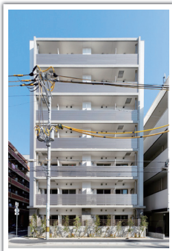
(仮称)都島内代町マンション 新築工事 設 計 者:株式会社 ジオプランニング 完 成 日:2019年1月31日 構造・規模:RC造・7階 施工床面積:881㎡
