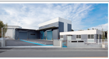
有限会社テクノゴロー本社・工場 新築工事 設 計 者:自社 完 成 日:2018年12月30日 構造・規模:S造・2階 施工床面積:1,106㎡
