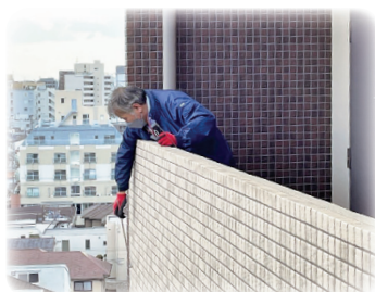
建物点検の様子
