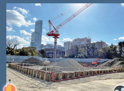
3月初旬の現場風景です。 写真奥が天王寺動物園内です。
