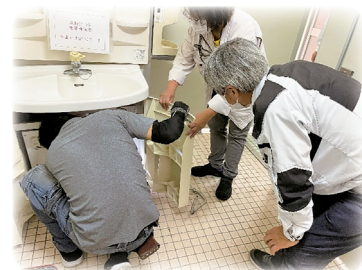
職人さんと打合せしながら作業確認の様子
